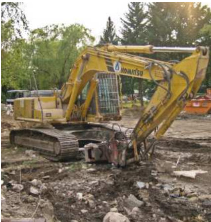
Bagger, Blick nach SW
