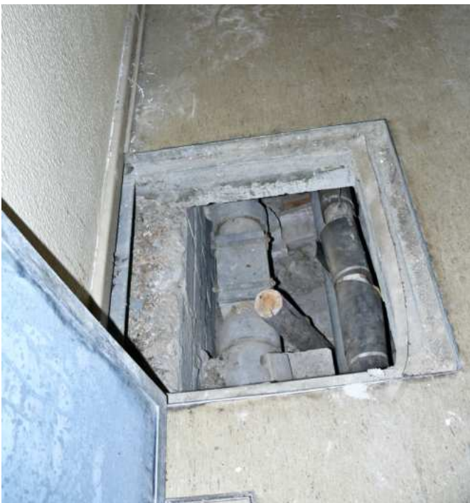
Rohre im Boden.
