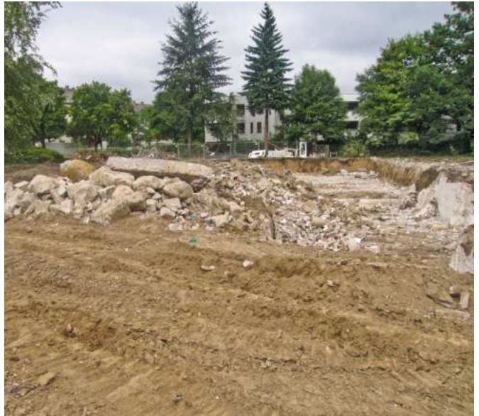
Grube und Bauschutt am ehemaligen Nordflügel
