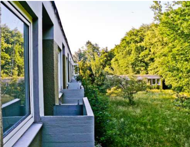
J Südflügel-Ostseite mit Blick auf den Ostflügel
