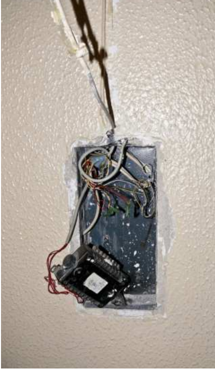
Geöffneter Verteiler
