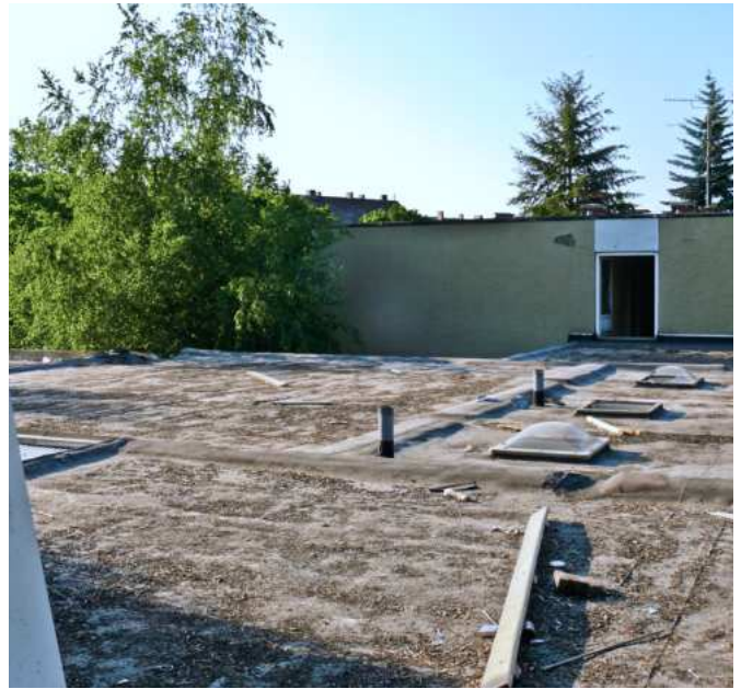
oben: Blick über das Mittelteil
