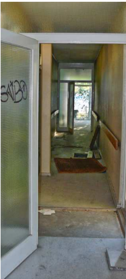
unten: Gang im OF, Blick zum Eingang nach Westen
