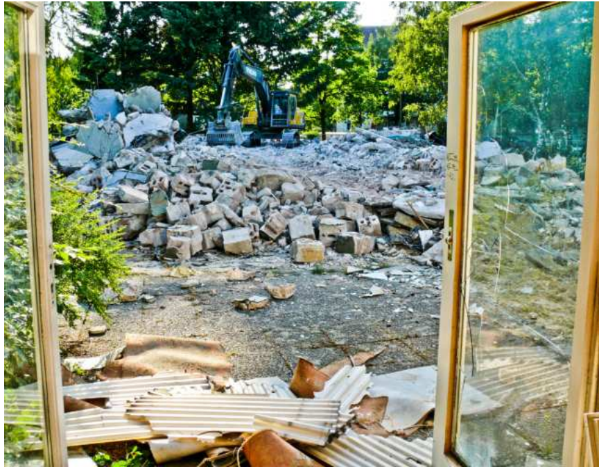
Bauschutt des Westflügels mit Bagger
