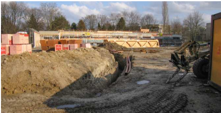
Die Mauern stehen, der Eingangsbereich ist abgestützt
